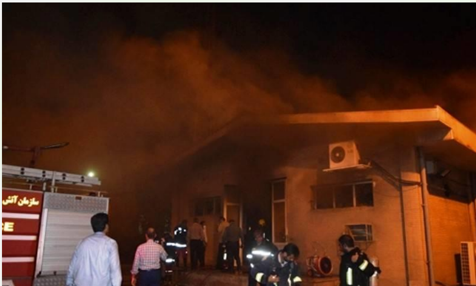
شکل ۱۴: آتش سوزی ترانس پست سپیدار در خوزستان در اثر موج گرما، ۱۳۹۶
