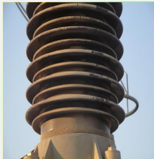
شکل ۴: اثر گرد و غبار بر مقره‌ها و پوشینگ‌های خطوط و پست‌های انتقال
