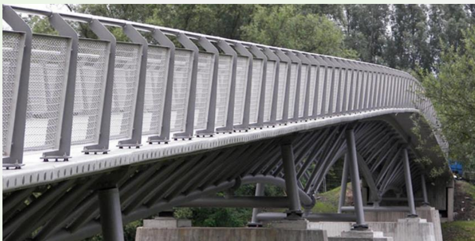
شکل ۲: پل Gärtnerplatz در آلمان با بهره‌گیری از بتن پرمقاومت با استفاده از تکنولوژی نانو برای دال بتنی پل
