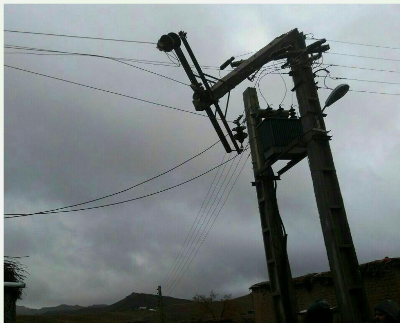
شکل ۱۱: شکستگی و کج شدن تیرهای برق در اثر وقوع سیل در شهر بابک در سال ۱۳۹۵
