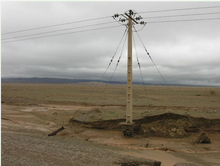
شکل ۵: شسته شدن پایه تیرهای برق در اثر وقوع سیل در خراسان جنوبی در سال ۱۳۹۲
