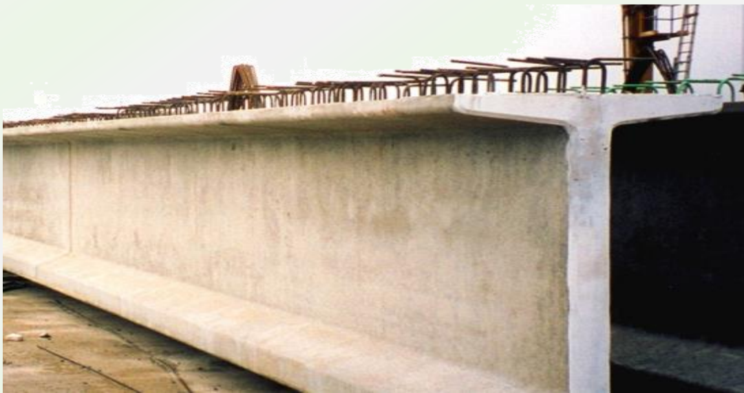
شکل ۴: رکاب های فولادی شاه تیر بتنی پل که از فولاد MMFX2 استفاده شده است - اوکلهاما-امریکا
