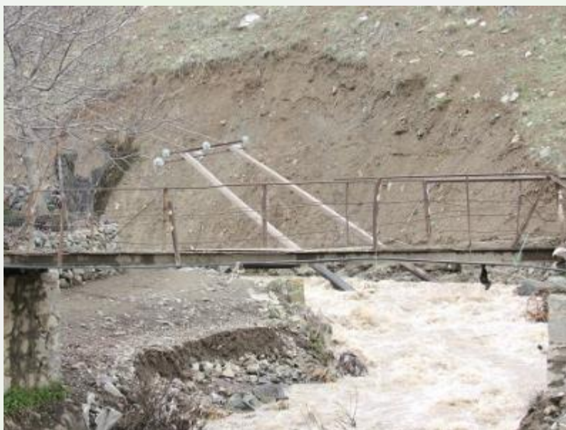
شکل ۷: خرابی تیرهای برق در اثر وقوع سیل در زنجان سال ۱۳۹۵
