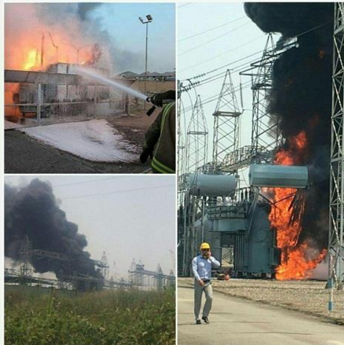
شکل ۱۳: آتش سوزی پست برق در ۷ مرداد ۱۳۹۶ در مازندران
