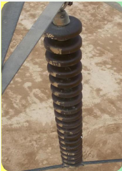
شکل ۴: اثر گرد و غبار بر مقره‌ها و پوشینگ‌های خطوط و پست‌های انتقال
